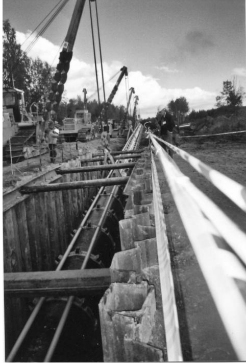
Рисунок 6. Расположение рабочего трубопровода в спусковой дорожке
