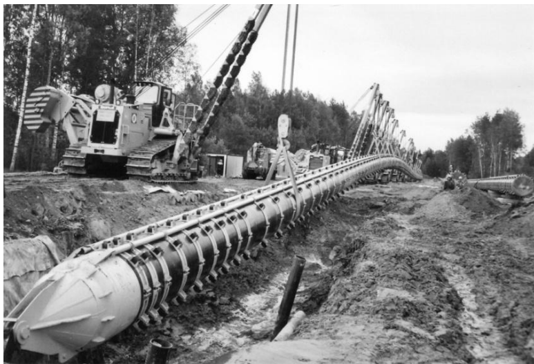
Рисунок 4. Начало протягивания рабочего трубопровода на переходе через р. Неву
