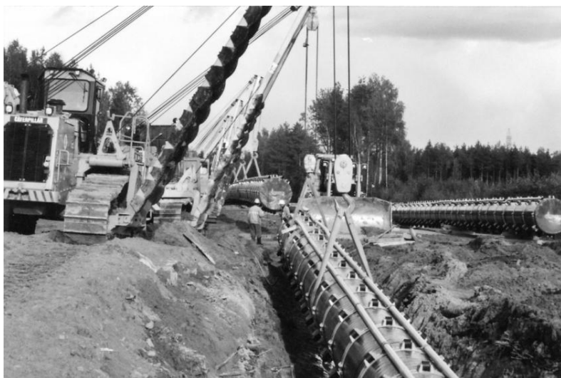
Рисунок 5. Нарращивание рабочего трубопровода очередной плетью
