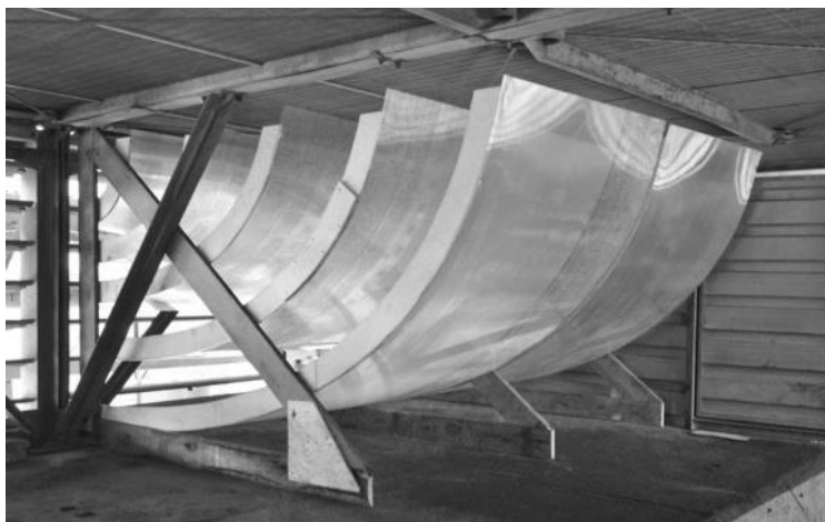
Рисунок 3. Направляющий аппарат (половина) смонтированный в подсекционном пространстве АВОм
