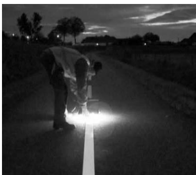
Рисунок 4. Нанесение разметки
