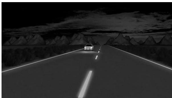
Рисунок 2. Разметка дороги из фотолюминесцентных элементов
