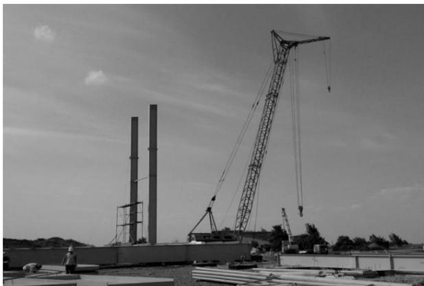
**Фото 1. Укрупнительная сборка монтажного блока покрытия ангара**
