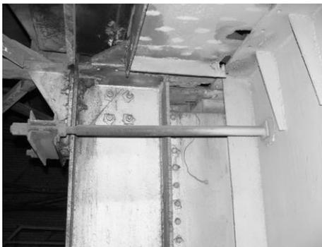
**Рисунок 4.** Узел крепления подкрановых балок
