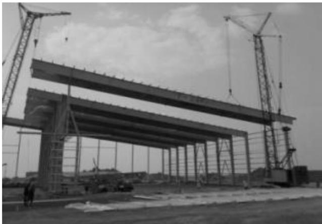
**Фото 2. Монтаж блока покрытия ангара двумя кранами**
