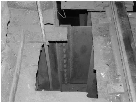
*Рисунок 1. Узел крепления подкрановых балок*
