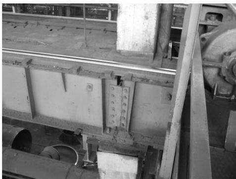
*Рисунок 2. Узел крепления подкрановых балок*
