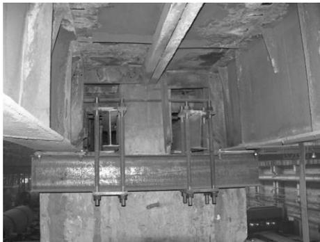
**Рисунок 6. Узел крепления подкрановых балок**
