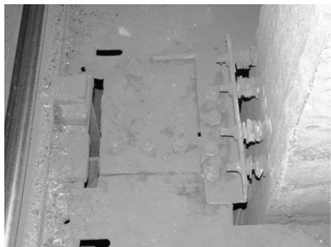
*Рисунок 3. Узел крепления подкрановых балок*
