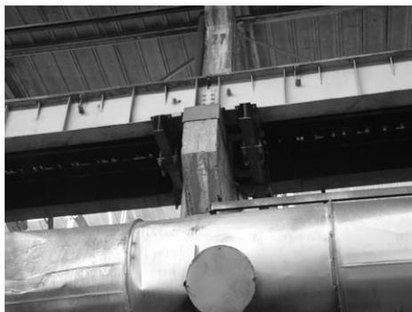
**Рисунок 5.** Узел крепления подкрановых балок
