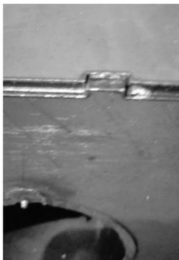
*Рисунок 3. Соединение типа «шип-паз»*
