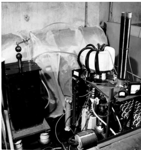
Рисунок 4. Однокаскадный импульсный трансформатор
